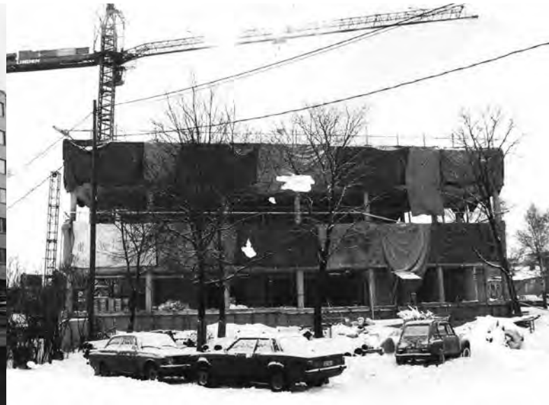
Turun terveystaloa rakennettaessa talvi oli kylmä ja katon raudoitustöitä tehtiin tulipalopakkasessa. Harjakaispäivää vietettiin 22.1.1981.
